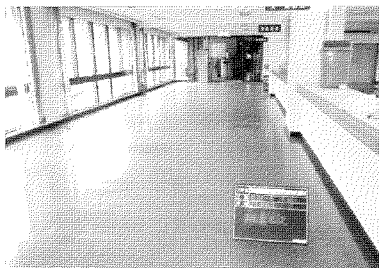
本部棟2階窓口（着工前）
