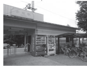
赤坂駅の駅舎。無人駅だが、利用者が多い
