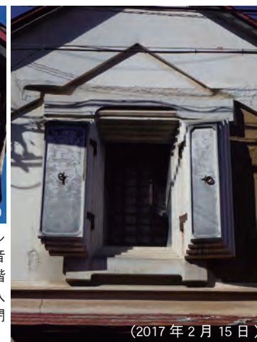
左：蔵の壁はところどころ素材がむき出しになっている 中央：蔵の二階の窓。観音開きの扉と、その内側に障子がある。一階の窓は板で閉め切っていた 右：蔵の入り口。窓と同じく観音開きの扉と障子で閉められている
