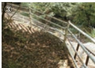
階段は手すりがあるが一段の幅が狭く、登りにくい
