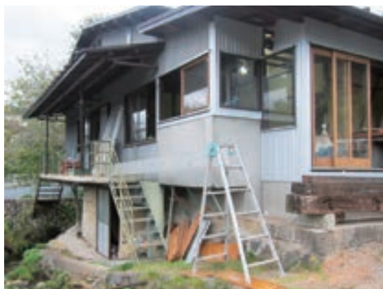
落合水路橋を背に、小屋を撮った写真。窓が多く、引き戸もガラス張りになっている(2018年10月12日)
