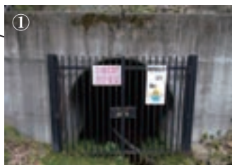
本坑の入口。高さは約1メートル
