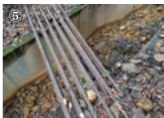
水路の橋渡しとして線路のレールが使われていた
