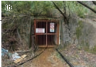
本坑のさらに上(階段を登ったさき)にあった坑。本坑と同じく高さは1メートルほどであった
