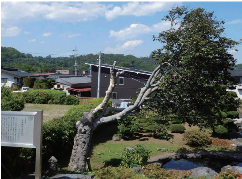
上：2年前に撮影された、枝を伐採する前のヤブツバキ（写真提供＝都 留市役所 観光課）下：枝を伐採した後のヤブツバキ。枝が倒れないよう に、ワイヤーで固定されている（2019年5月24日）
