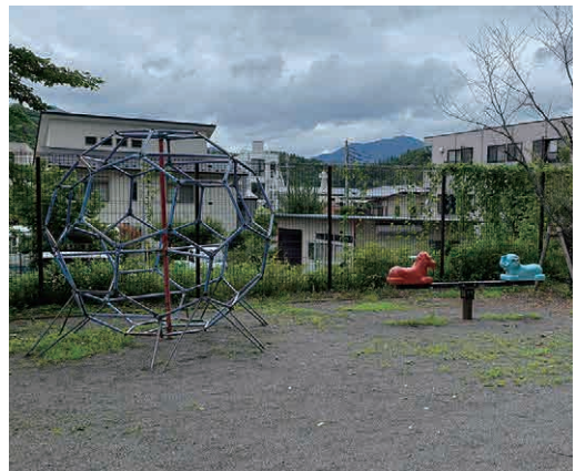
つるの子公園の遊具。あまり使われていない。色が落ちていたり、錆びたりしている
