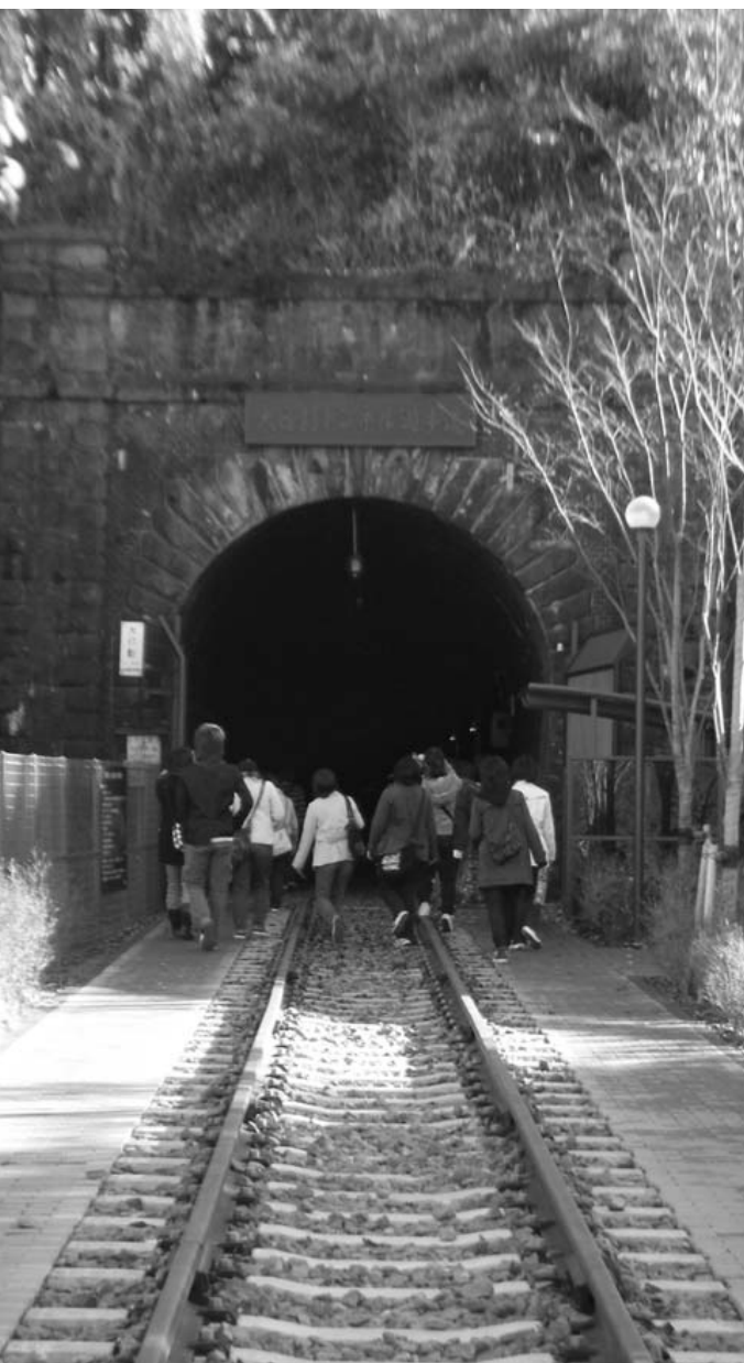
1903年に開通した大日影トンネル（現在は遊歩道）
