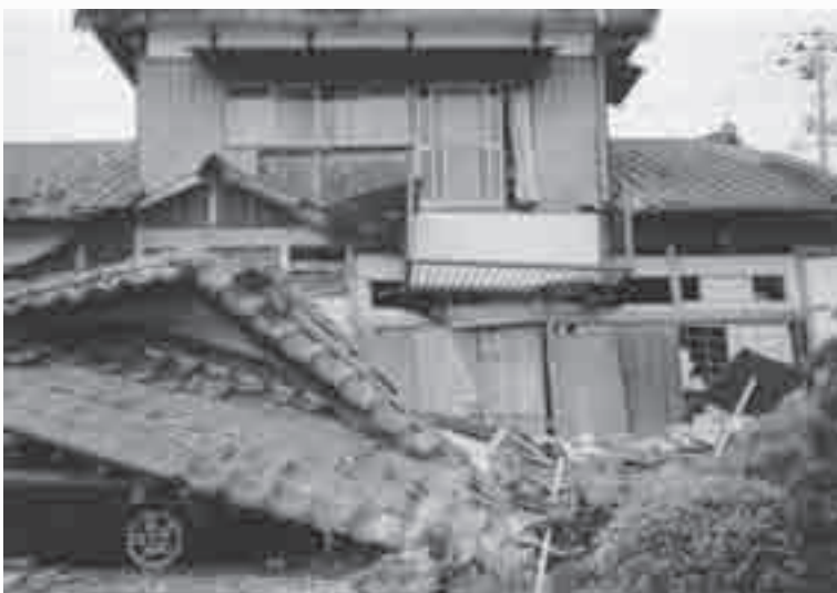
全壊した実家 (福島県いわき市)
