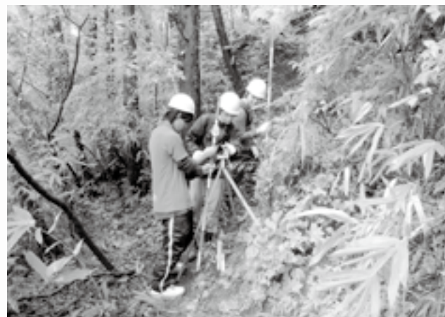
道を作り、測量をす
