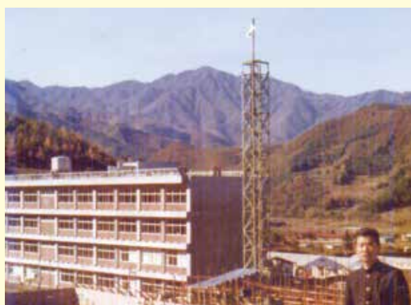
写真1 昭和40年2月、大学1号館建設現場を見下ろして。自分たち英文学科1期生はこの校舎で授業を受ける事は出来なかった
