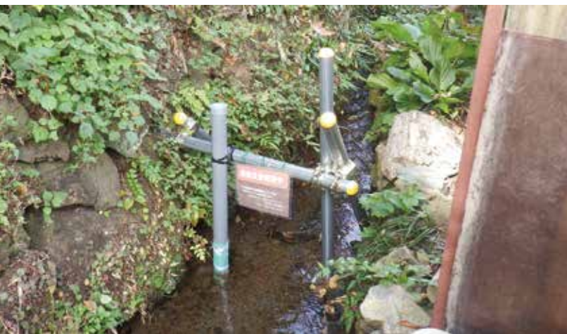
写真1 連続水位観測装置の設置状況
